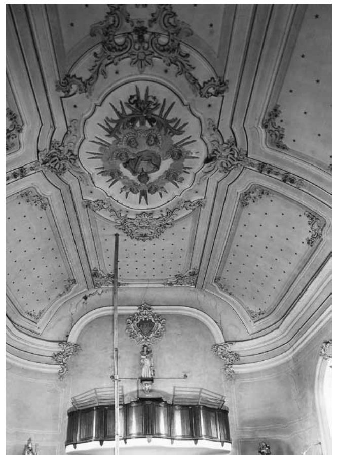
Vue d'ensemble du plafond de la nef. Ancien surpeint encore visible (© KIKIRPA 1944)
