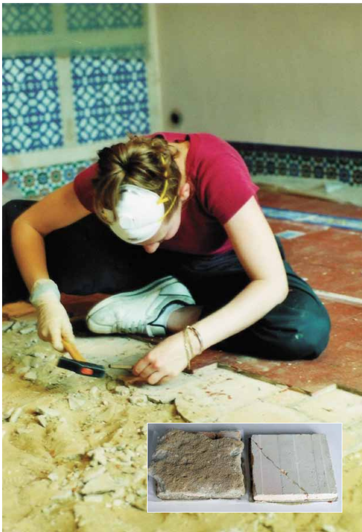
En cours de dépose, on observe successivement: le lit de sable, la chape de ciment et le carrelage Détail: A gauche, un cabochon avant préparation à la repose et à droite, un cabochon nettoyé et recollé
