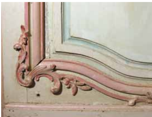
Détail des moulures et des sculptures d'un encadrement après dégagement de la dorure 19 ème et des surpeints
