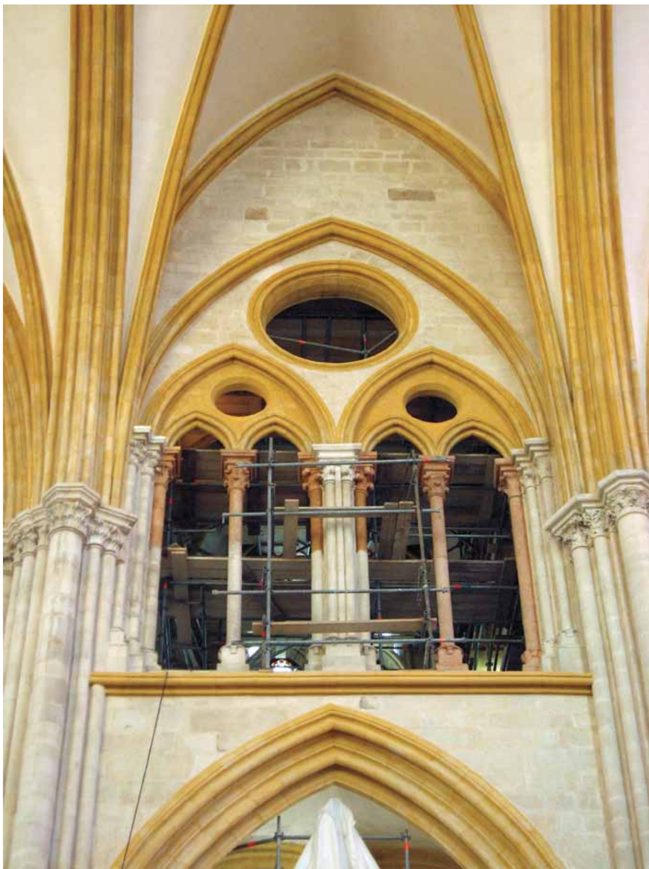
Bras sud du transept, mur est, naissance des arcs et baie de la chapelle haute sud du chœur: l'application du badigeon ocre jaune est finie, celle du rouge pâle est en cours; les zones encore humides sont momentanément plus foncées
