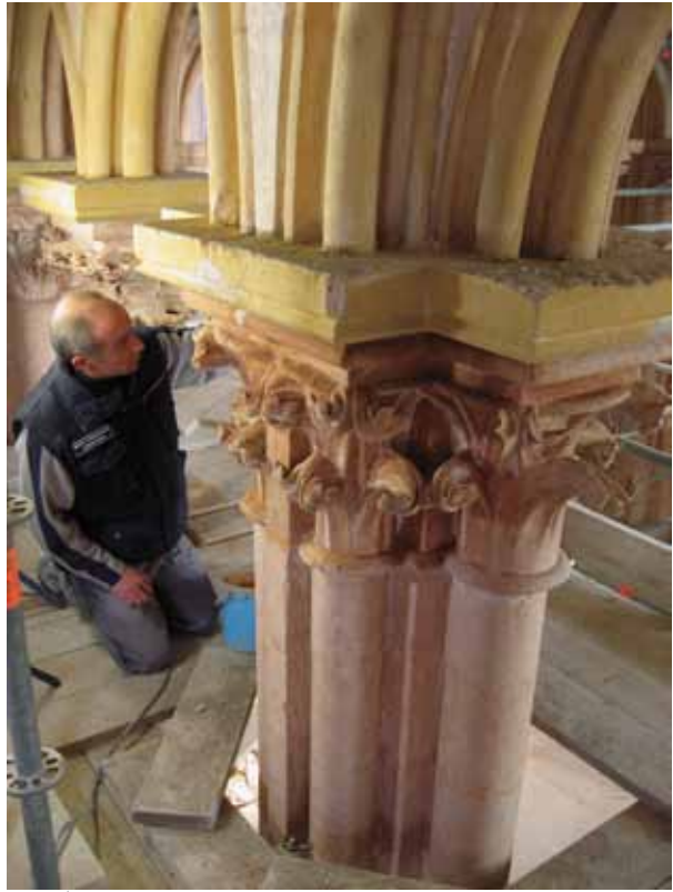
Travée ouest du cœur, détail pendant l'application par le maçon de la teinte rouge pâle sur les colonnettes et les chapiteaux, en contourant les vestiges d'origine, identifiés et signalés lors de l'étude préalable des surfaces
