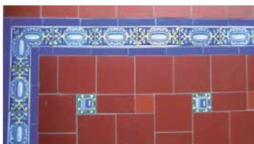
Détail du décor après traitement, mélange d'éléments restaurés et de copies
