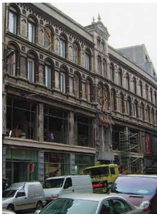
Façade de La Grande Maison de Blanc, rue Marché aux poulets à Bruxelles, avant traitement
