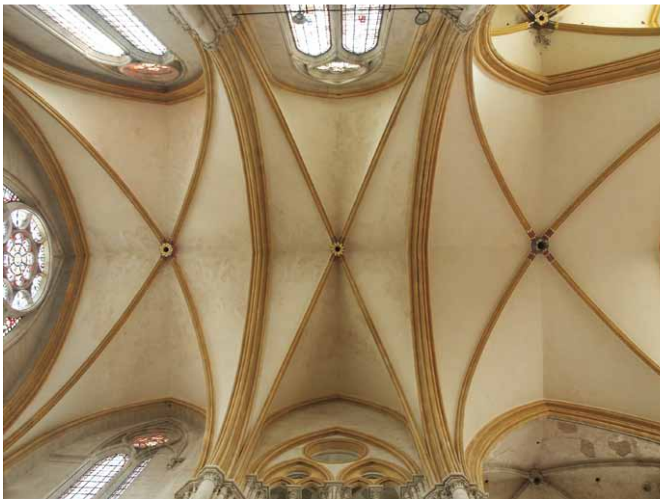
Toul, voûtes du bras nord du transept et de la croisée après restauration
