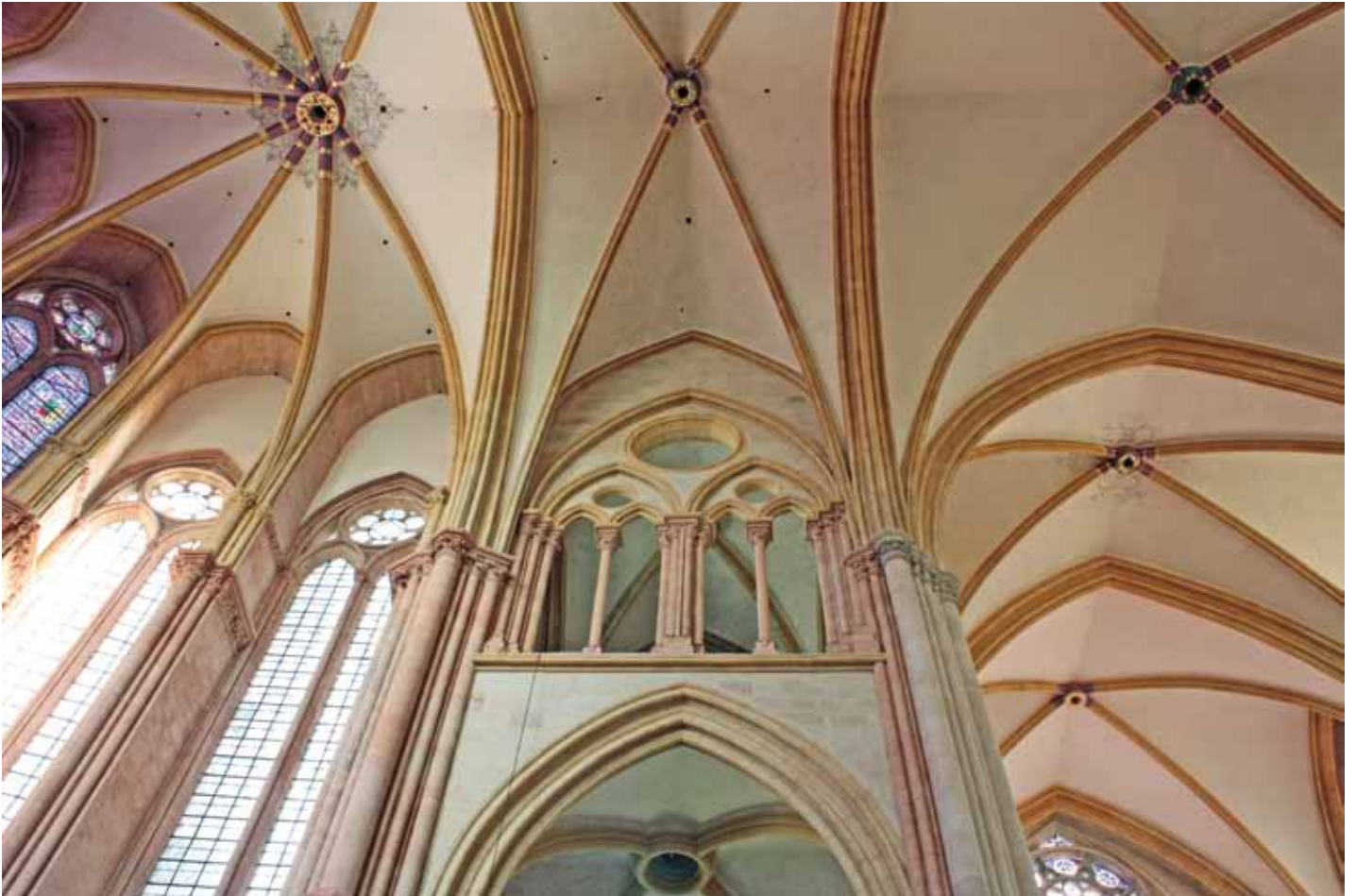
Chœur, voûtes et partie haute du mur sud après restauration: à droite, les voûtes du transept. Tous les enduits des voûtes d'origine ont été conservés, consolidés et dégagés des badigeons tardifs superposés. La polychromie et la dorure des clés de voûte ont été reconstituées après une étude minutieuse des restes de couches colorées. La découverte de traces de décor autour de deux des clés de voûte a permis la reconstitution plus ou moins intense de ces décors, en fonction de la certitude et de la lisibilité des vestiges.
