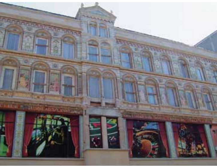
Ensemble de la façade après intervention: les vitrines du rez de chaussée doivent encore être remplacées
