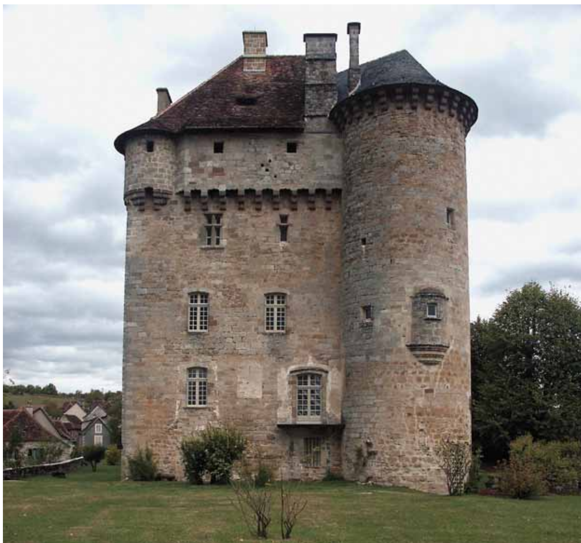
Curemonte en Corrèze, château de Plas, façade sud
