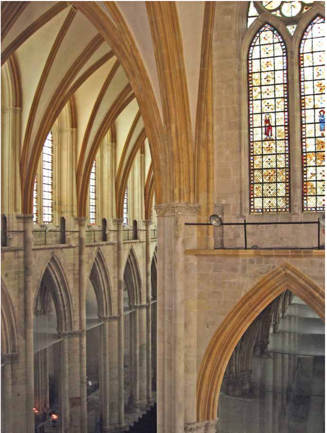
Toul, angle du bras nord du transept (à droite sur la photo) et de la nef: on remarque au premier plan l'application, lors du chantier, du badigeon ocre jaune légèrement transparent et dont la saturation décroît légèrement vers la naissance des arcs
