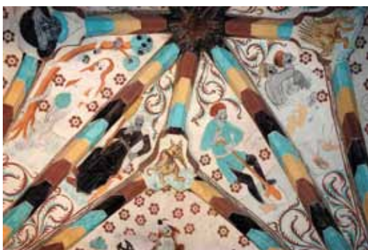
Nooit overkalkte muurschilderingen in de kerk van Häckeberga (Zweden) met onomkeerbare chemische verandingsprocessen: het azurietblauw is groen geworden en het vermiljoenrood is bruinzwart verkleurd.
