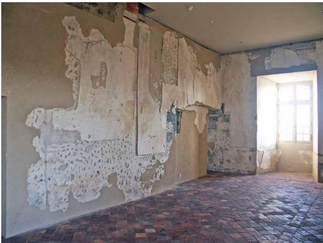
Curemonte, 2 ème étage, salle ouest, murs est et sud après restauration: dans les zones où la maçonnerie visible dans les lacunes des enduits troublait trop la lecture des enduits et des décors, une couche d'enduit de restauration proche de la texture et la nuance du dégrossi (arriccio) d'origine a été appliquée entre les fragments et vestiges anciens
