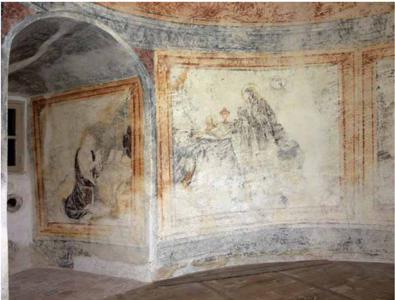
Curemonte, chapelle oratoire dans la tour sud-ouest, représentations de St. Jérôme et Ste. Marie Madeleine: le décor peint datant du 17 ième siècle, qui avait perdu sa matière picturale en grande partie lors d'un dégagement brutal antérieur, a été restauré de façon restreinte en atténuant les surfaces blanches des lacunes et avec la suggestion très discrète des éléments décoratifs rythmant la composition, là où ils avaient disparu
