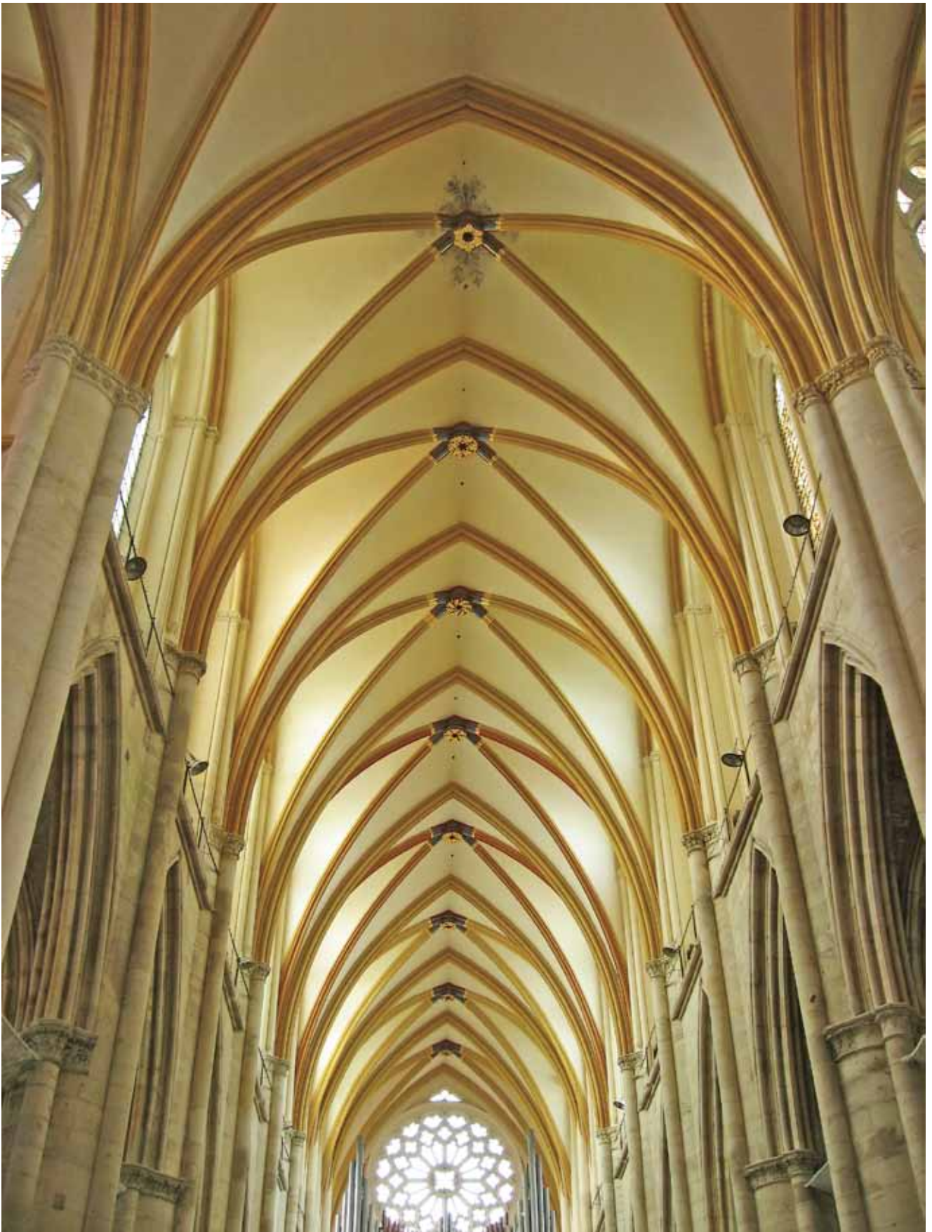
Toul en Meurthe-et-Moselle, cathédrale Saint Etienne, vue de la voûte de la nef, restaurée déjà avant l'intervention dans le transept et le chœur
