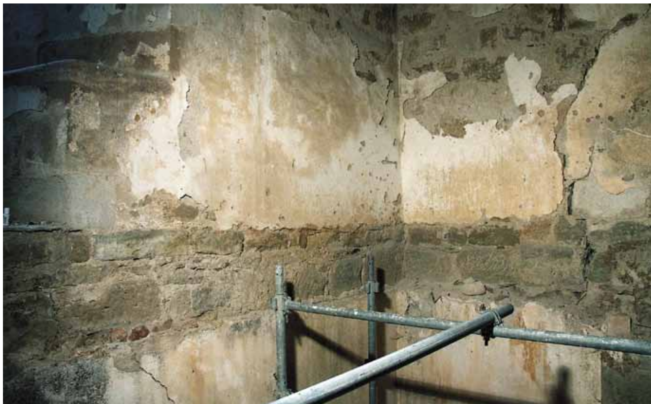
Curemonte, angle nord-ouest des mêmes salles, lors du début des travaux : tous les enduits ont été conservés et consolidés lors du chantier
