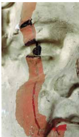
Détail du sondage stratigraphique réalisé dans les carnations d'un ange du plafond du chœur: polychromie originale, premier surpeint au naturel et surpeints blancs
