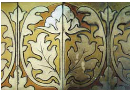
Éléments d'une frise en cours de nettoyage
