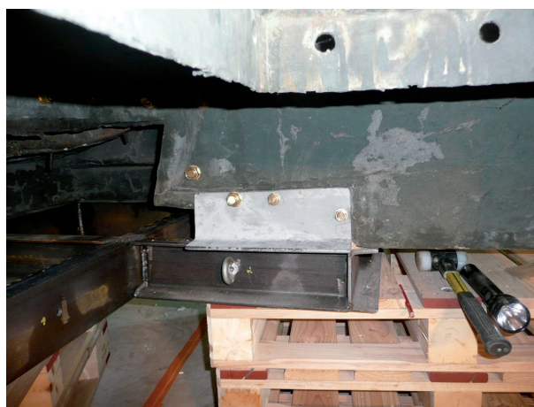
Support en fer peint pour reporter le poids de la statue directement au sol. Versteviging in beschilderd ijzer om het gewicht van het beeld aan de grond op te vangen.
