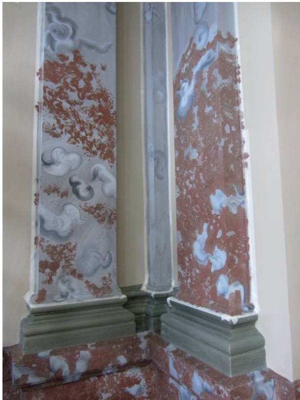
Peinture de faux-marbres en cours de réalisation. De marmerschildering tijdens de uitvoering.
