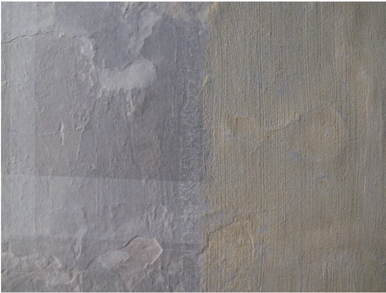
Fig. 3 A en B : Mechelen, Hof van Busleyden : permanente afdekking van een plintzone onder een 16de-eeuwse muurschildering : twee lagen hennep papier, gekleefd met celluloselijm, overdekking met kalkverf en zand, later overschildering met leemverf.
