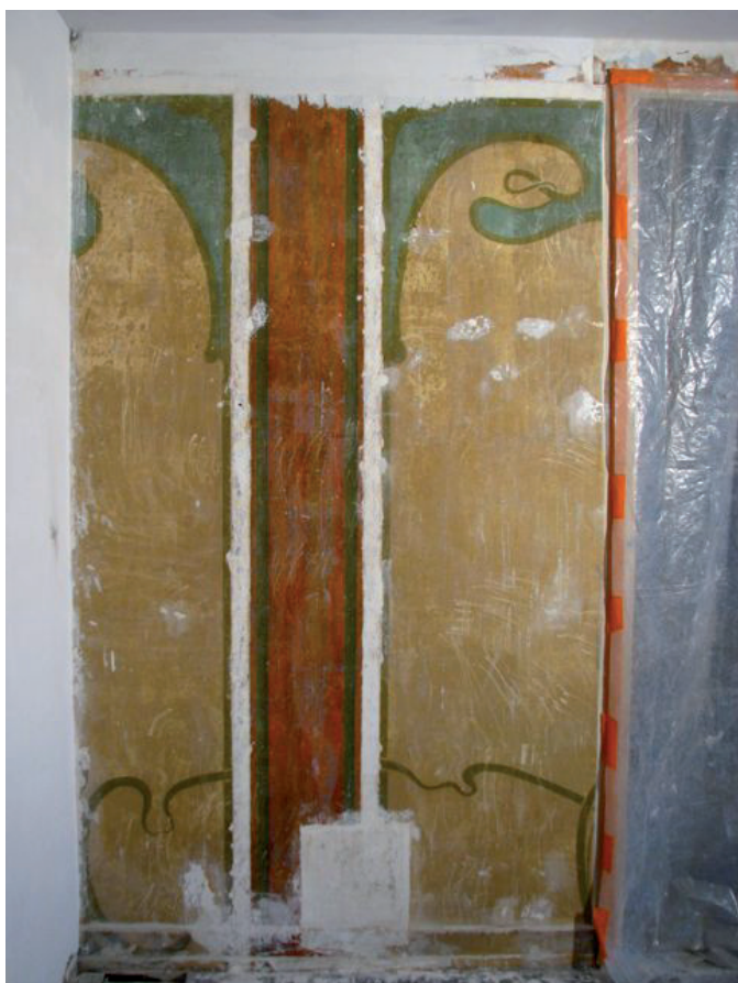
Fig. 1 A en B : Brussel, Horta, Hôtel Winssinger : rankenschildering in de traphal : permanente afdekking met hennep papier en dammarvernis, later overschilderd met acrylaatverf.
