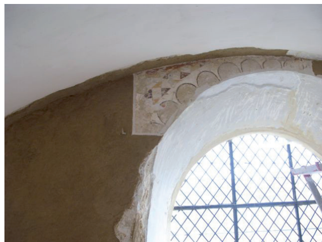
Fig. 4 A en B : Soignies, Collegiale kerk Sint-Vincentius, imitatie van natuursteen metselwerk : permanente afdekking met leem en overdekking met kalkpleister : test en opname tijdens behandeling.
