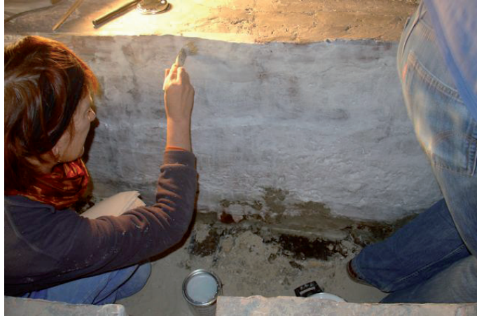
Fig. 5 A en B : Liège/Tongres, tombeau de Koninksem (Ive siècle) : protection provisoire au cyclododecan (liant volatil) et facing supplémentaire pour retarder l'évaporation pendant l'injection de la maçonnerie avec une résine époxy.
