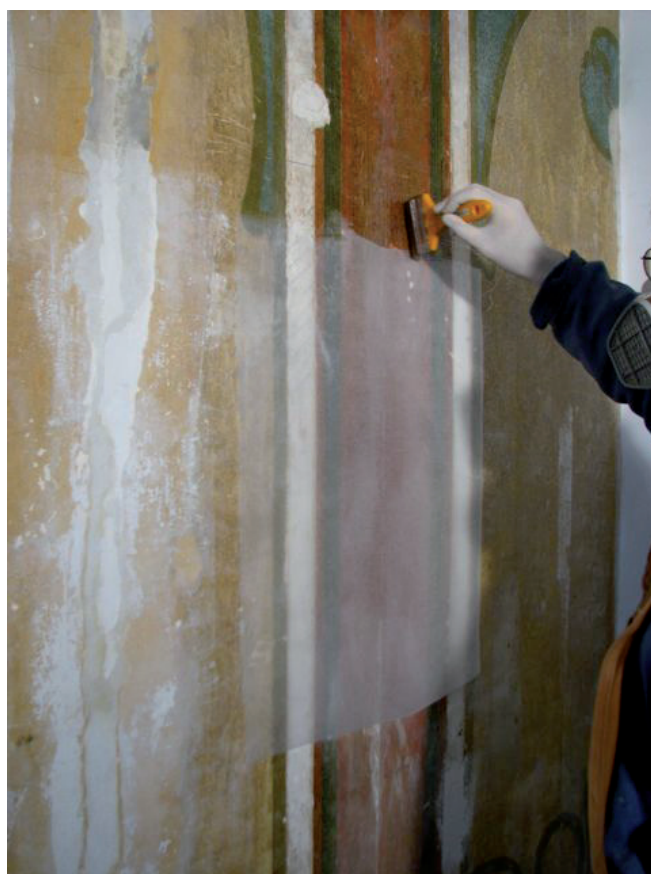
Fig. 1 A en B : Brussel, Horta, Hôtel Winssinger : rankenschildering in de traphal : permanente afdekking met hennep papier en dammarvernis, later overschilderd met acrylaatverf.
