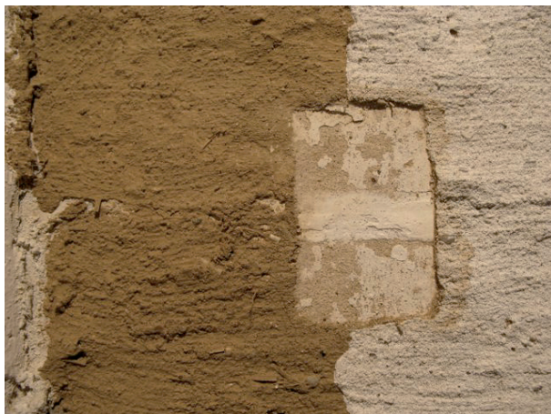
Fig. 4 A en B : Soignies, Collegiale kerk Sint-Vincentius, imitatie van natuursteen metselwerk : permanente afdekking met leem en overdekking met kalkpleister : test en opname tijdens behandeling.
